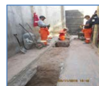
Trabajos de excavación para colocación de gatas en Muro 11.
