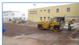
Se realiza compactación de pasillo circulación del Edificio de Estadísticas.
